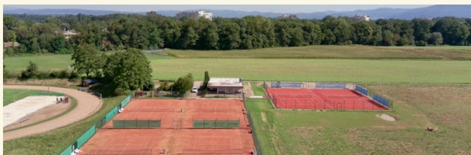
Der TC Umkirch bei Freiburg baute zwei neue Allwetter-Tennisplätze. Foto: Verein
