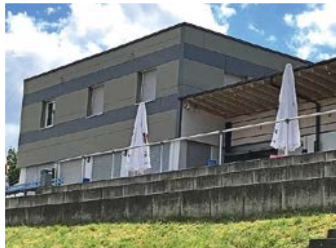
Das TSV-Vereinsheim präsentiert sich seit der Sanierung in neuem Glanz – optisch und energetisch. Foto: Verein
