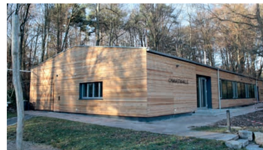
Mit der rundum sanierten Gymnastikhalle hat die SKG Botnang nicht nur eine moderne Sportstätte hinzugewonnen, sie spart auch hohe Energiekosten
