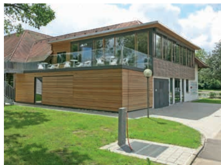
Das komplett umgebaute frühere Feuerwehrhaus in Illmensee. Foto: Olaf Brandt
